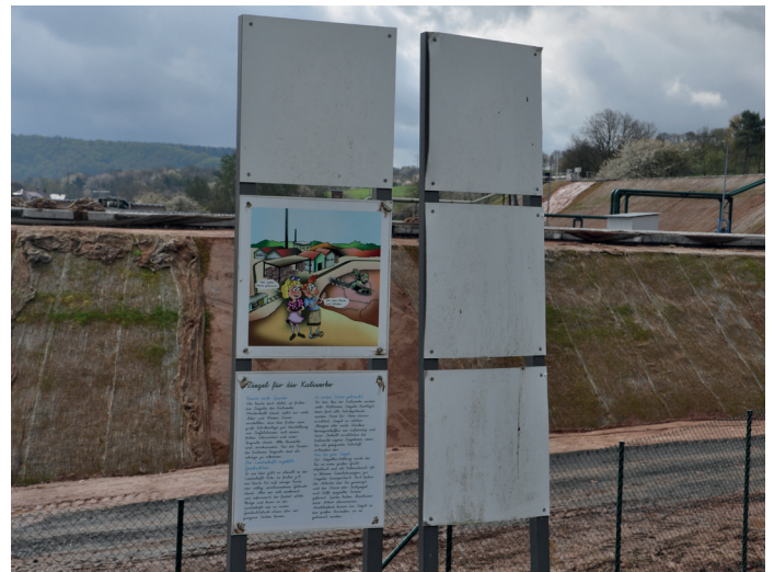
Abwasserstapelbecken der K+S KALI GmbH bei Bengendorf/ Wölfershausen
