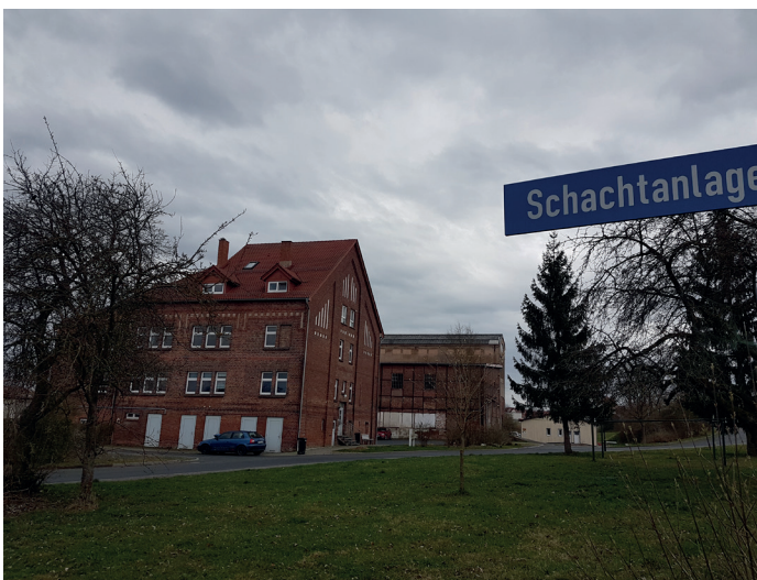
Dankmarkshausen – frühere Schachtanlage
