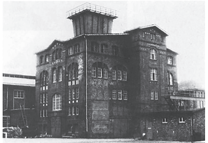
Foto: Die ehemalige Schachthalle an der Lengenser Straße zählt zu den eindrucksvollsten und typischsten Beispielen einer den Kalibergbau kennzeichnenden Architektur; Quelle: Landesamt für Denkmalpflege Hessen, Kulturdenkmäler in Hessen (1997)
