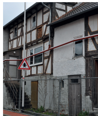
Gebäudezustand traditionelles Fachwerkhaus
