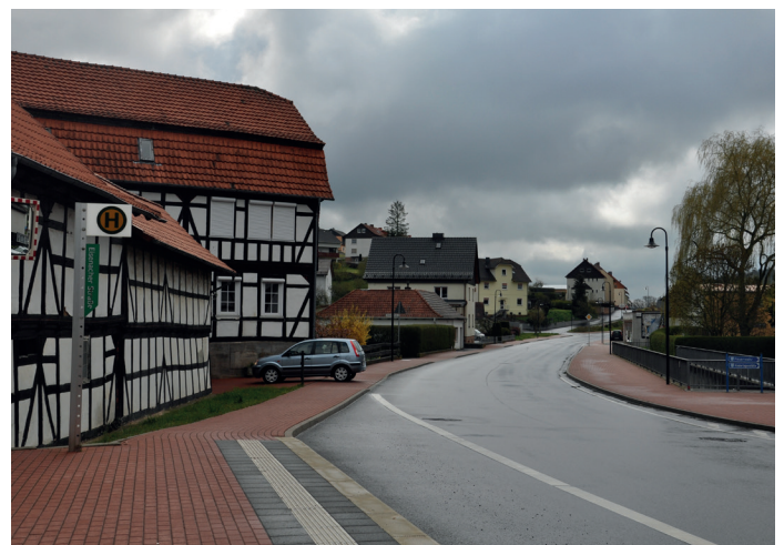
Sanierte Gehsteige Herfa
